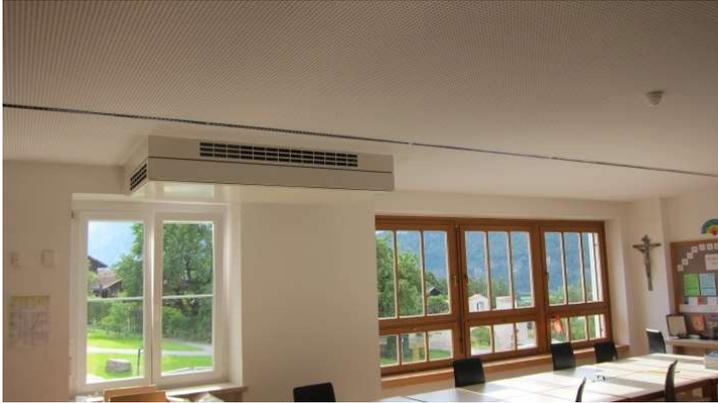
Abbildung 1: Korrekte Montage des Lüftungsgerätes in Bezug auf den Deckenspiegel (Zuluftauslass nach vorne, Abluftdurchlass seitlich links) aber perforierte Akustikdecke, dadurch kann sich der Coanda-Effekt nicht ausbilden. Abhilfe schafft hier das Abkleben der Löcher nahe beim Auslass (ca. 50 cm bis 1 m)
