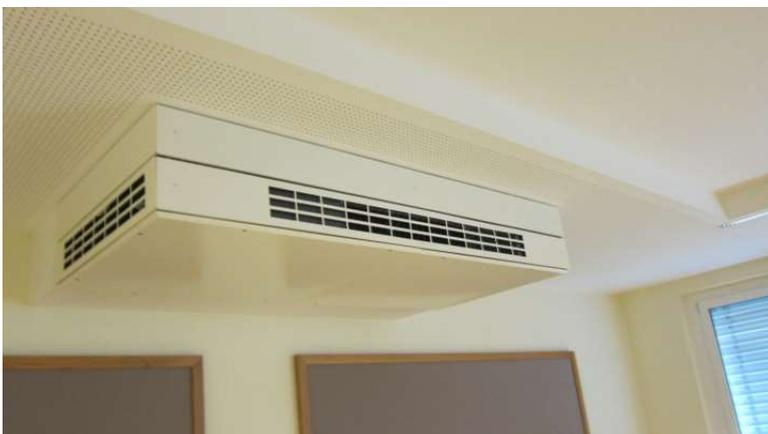
Abbildung 3: Perforierte Akustikdecke und Deckenversprünge führen zu Strömungsabriss, der Coanda-Effekt kann sich nicht ausbilden.
